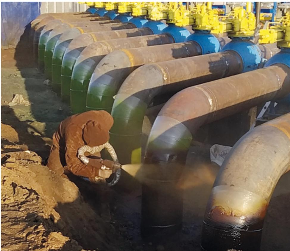
Нанесение изоляционного покрытия на измерительные трубопроводы DN400 ГИС-1
